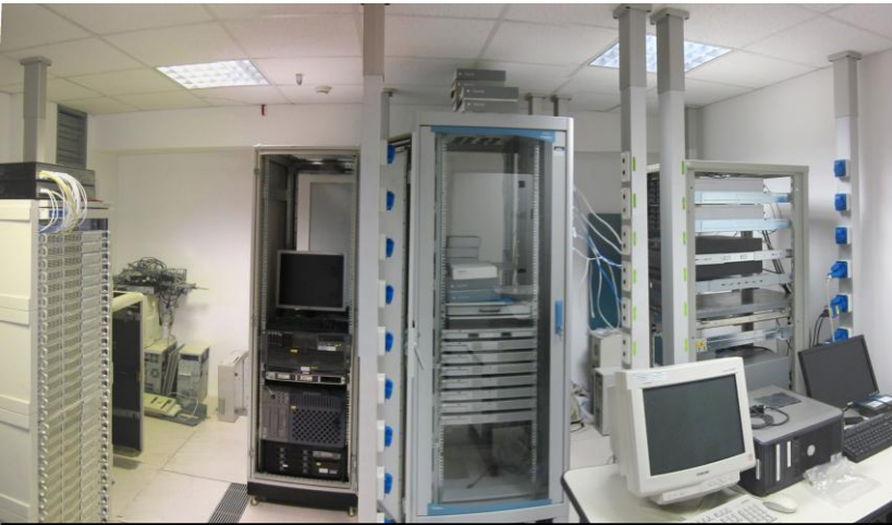
Fig 12 Scorcio di una delle due sale CED dell'OATo, in essa sono collocate delle macchine su cui sono residenti gli archivi elettronici di immagini astronomiche (OATo 2012)
